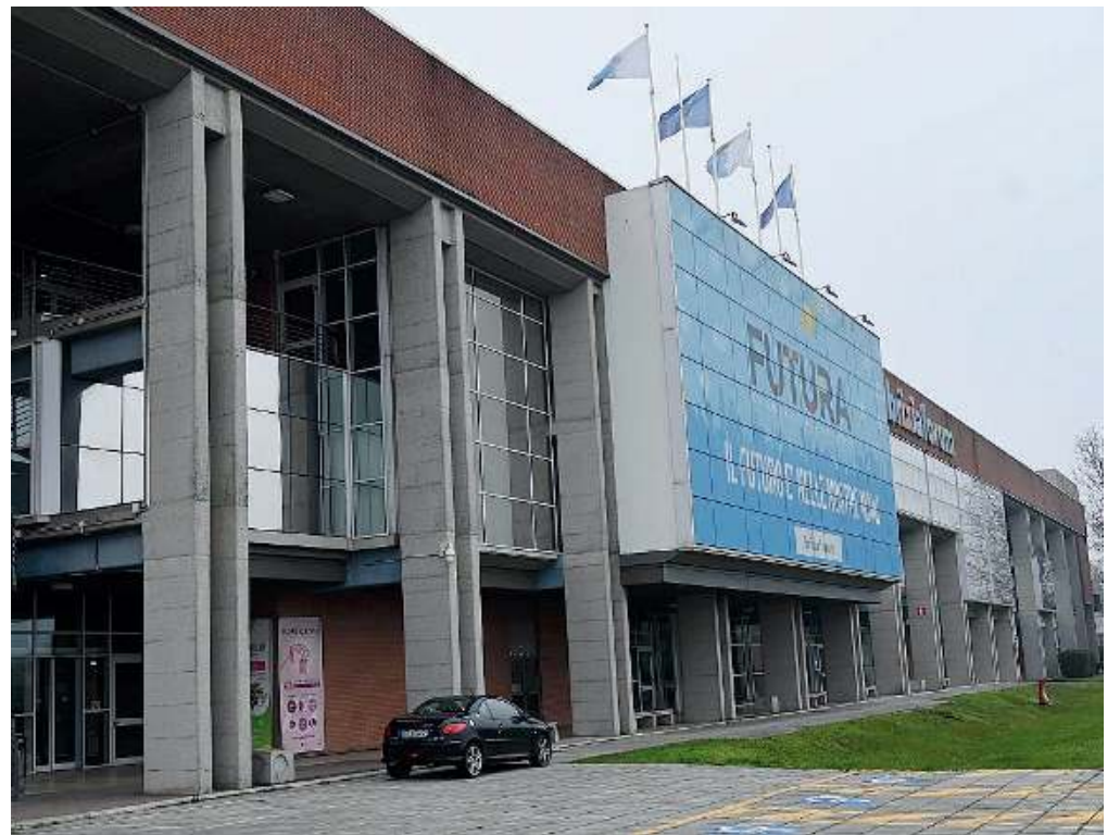
Riqualificato. La facciata del grande padiglione di Brixia Forum rinnovato negli impianti tecnologici
